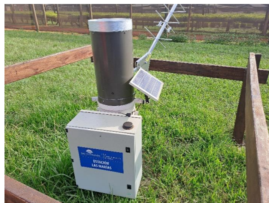
Figura 2.- Estación pluviométrica de la red telemétrica de Salto Grande con cerco perimetral de madera.
